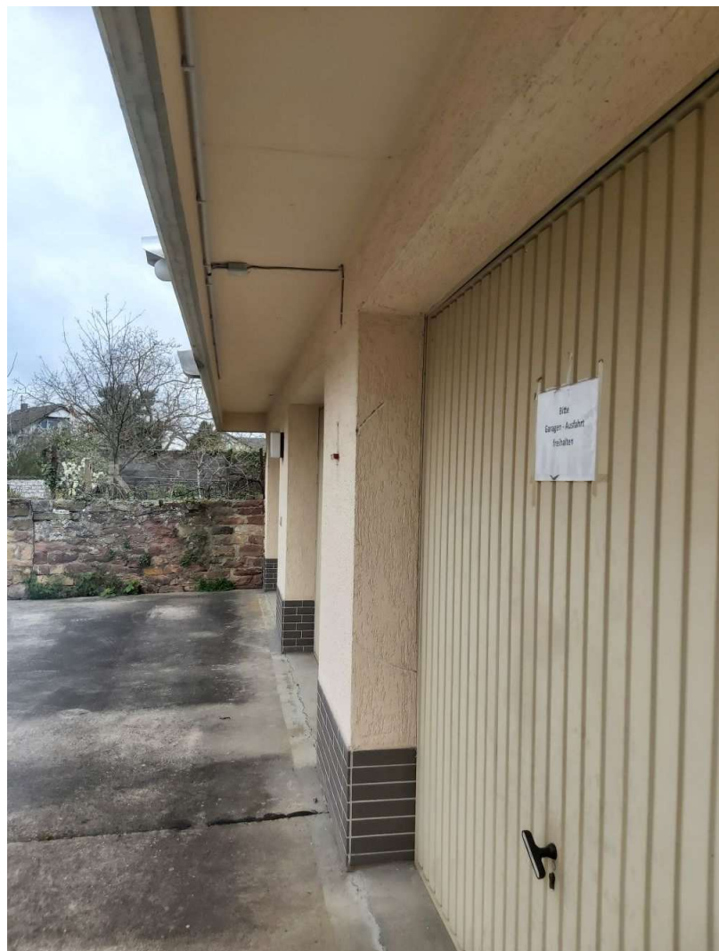
Foto 4: Vordach Garagen- gebäude
